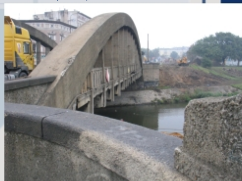
Projekt, który otrzymał największą kwotę dofinansowania w ramach ZPORR: przebudowa Mostów Warszawskich we Wrocławiu
