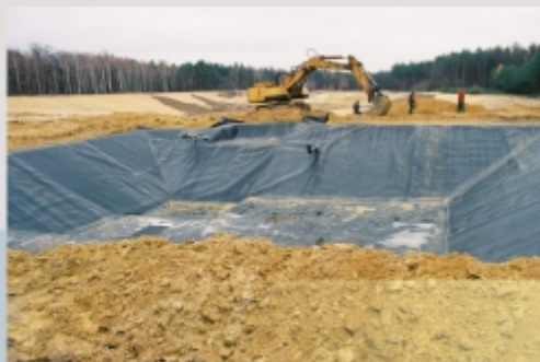
W dziedzinie ochrony środowiska dofinansowanie trafi m.in. na rekultywację składowisk odpadów
