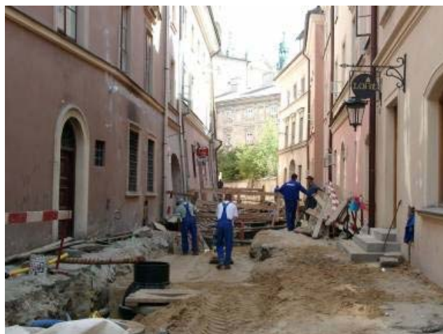
Ulica Jezuitska w Lublinie w trakcie realizacji projektu.
