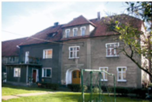
Fot. 10. Budynek mieszkalny z 1923 r.
