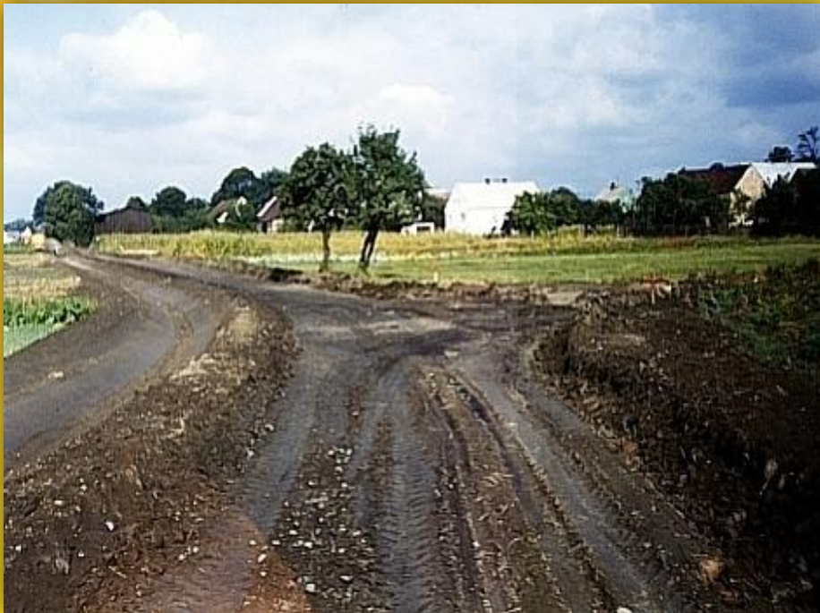
stan przed przebudową
