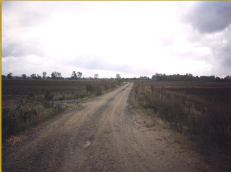
stan przed przebudową
