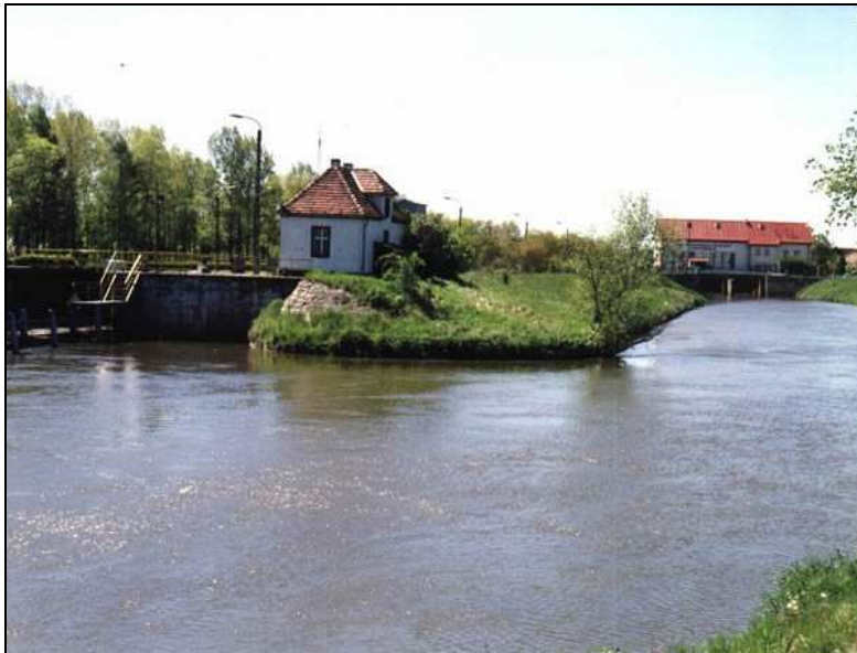
Rys. 9 Elektrownia wodna w Janowicach
