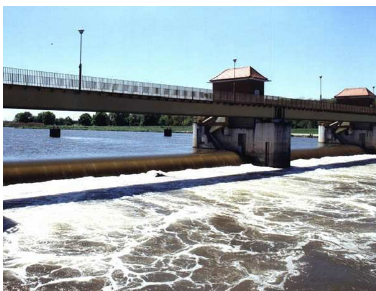
Rys. 8. Jaz na Odrze w Ratowicach
