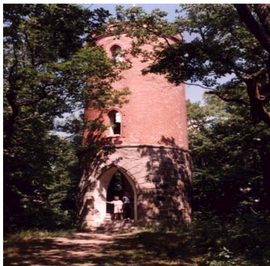
Rys. 10 Wieża widokowa, Kłonice
