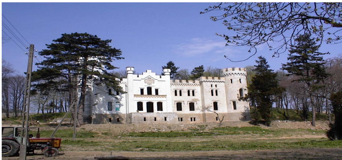
Rys.6 Pałacyk w Myśliborzu (w trakcie remontu)
