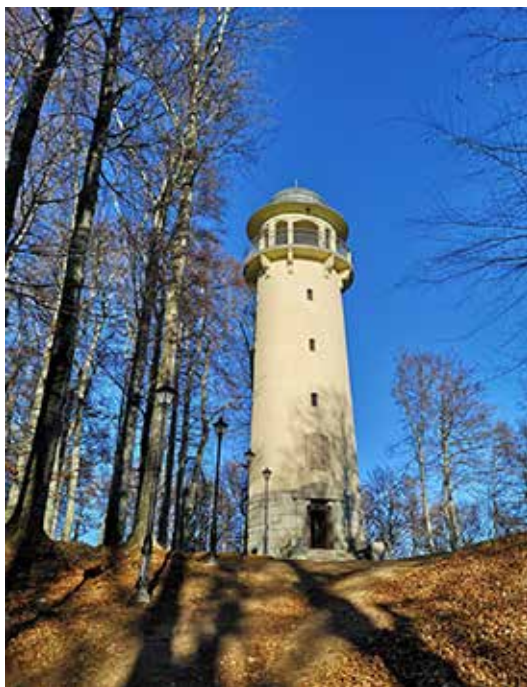
Wieża na Wzgórzu Krzywoustego
