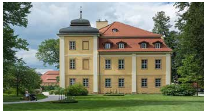
Pałac Łomnica – widok od południowego wschodu
