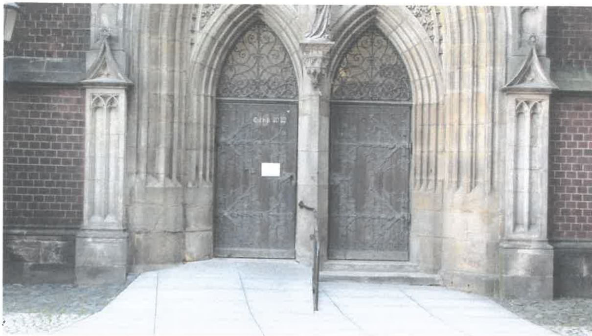
Fot. 5 Legnica, Gotycki portal, elewacja zachodnia Katedry Świętych Apostołów Piotra i Pawła w Legnicy, XV w. Widok na drewniane drzwi. Widoczny stan zachowania elementów drewnianych oraz metalowych okuć drzwi. Fot. Mateusz Stankiewicz 2022.
