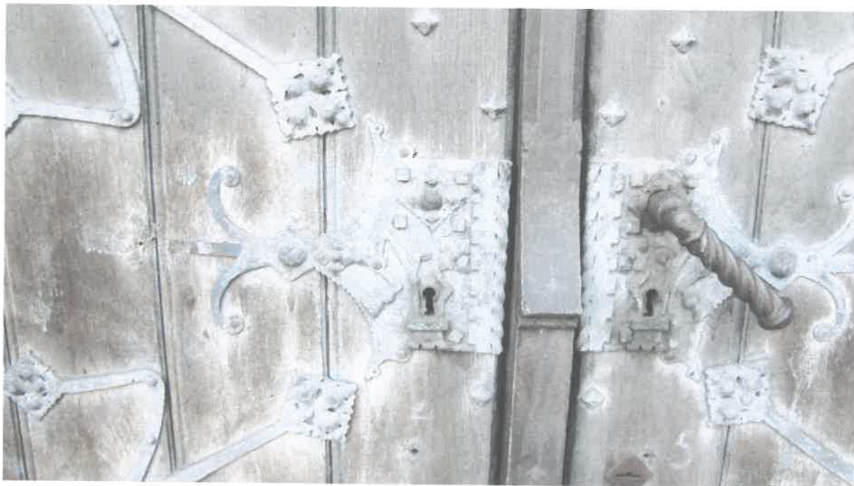
Fot. 8 Legnica, Gotycki portal, elewacja zachodnia. Katedry Świętych Apostołów Piotra i Pawła w Legnicy, XV w. Żelazne szyldy i brak klamki. Widoczny stan zachowania elementów metalowych. Fot. Mateusz Stankiewicz 2022.
