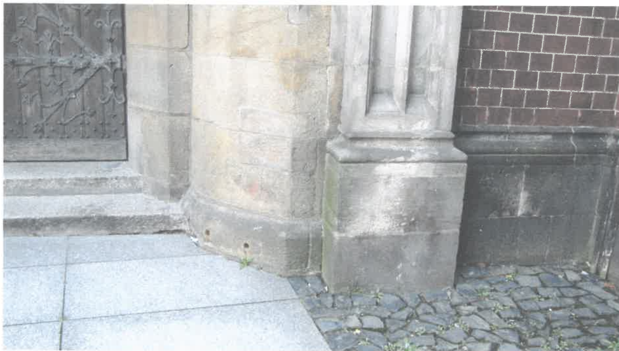
Fot. 2 Legnica, Gotycki portal, elewacja zachodnia Katedry Świętych Apostołów Piotra i Pawła w Legnicy, XV w. Widok ogólny. Widoczny stan zachowania elementów kamiennych. Fot. Mateusz Stankiewicz 2022
