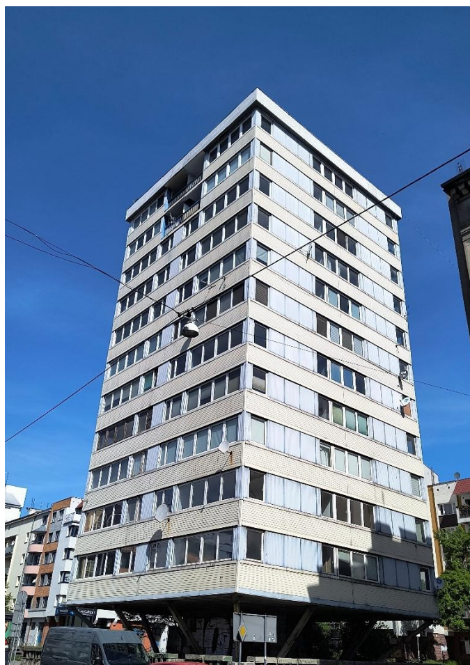
Fot. 40. Wrocław, ul. T. Kościuszki 72. Trzonolinowiec, budynek mieszkalny o unikatowej konstrukcji. Projekt powstał w latach 1957-63, natomiast realizacja w latach 1963-67. Jeden z najmłodszych dolnośląskich zabytków, wpisany do rejestru w roku 2023. Fot. M. Kaluch – Tabisz
