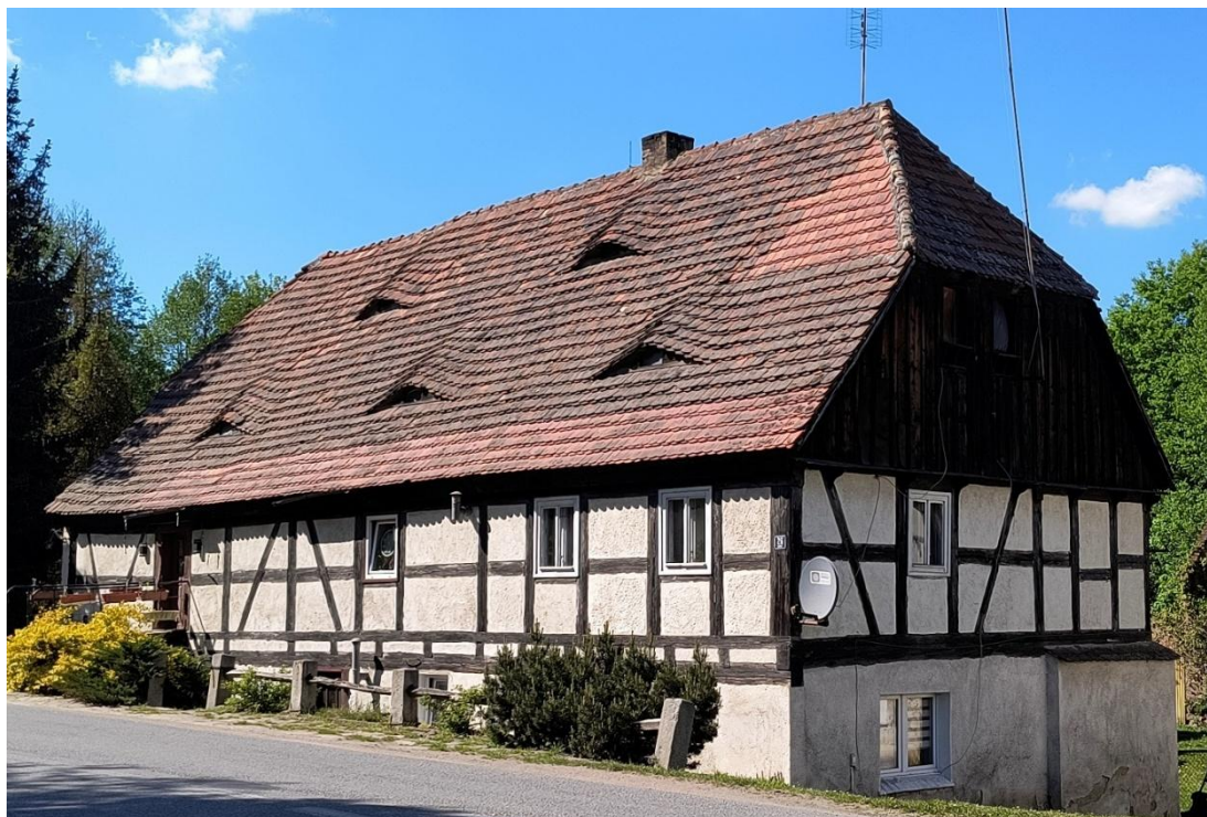
Fot. 21 Młyn wodny w miejscowości Sarby, gm. Przeworno. Budynek prezentuje charakterystyczny typ budownictwa spotykany na Dolnym Śląsku do początków XIX w. Kamienna lub ceglana, otynkowana podmurówka i piętro w drewnianej konstrukcji szkieletowej. Przestrzenie między drewnianymi belkami wypełniane były słomą, gliną, cegłami lub lokalnie zebranymi kamieniami polnymi. Charakterystyczny, wysoki dach naczółkowy z oknami powiekowymi, dodatkowo deskowanie na ścianie szczytowej. Fot. M. Kaluch – Tabisz
