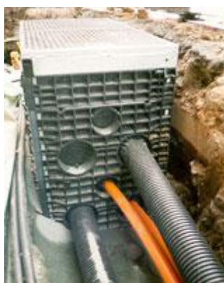
Rysunek 27. Przykładowe studnie z HDPE
