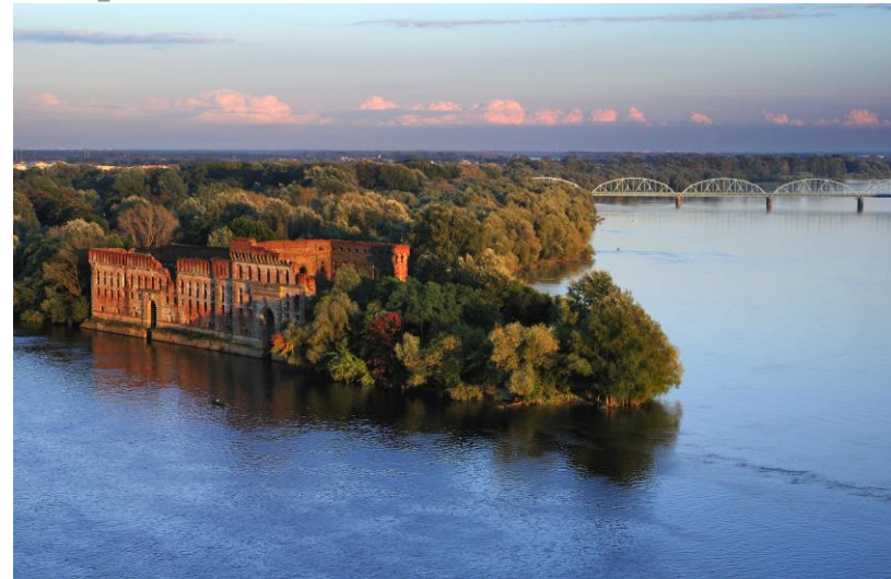
Foto: PZ Studio, Ruiny zabytkowego spichlerza u ujścia Narwi do Wisły
